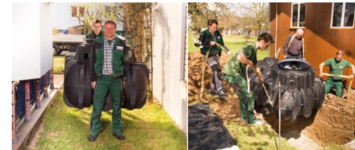
Der Tank wird in der Baugrube platziert. 59-03
