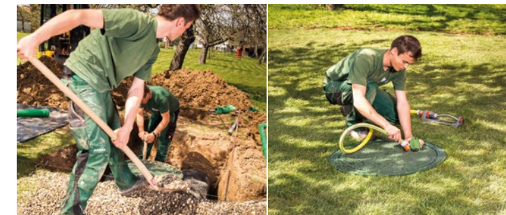
Mit Rundkornkies wird aufgefüllt und verdichtet. 59-05
