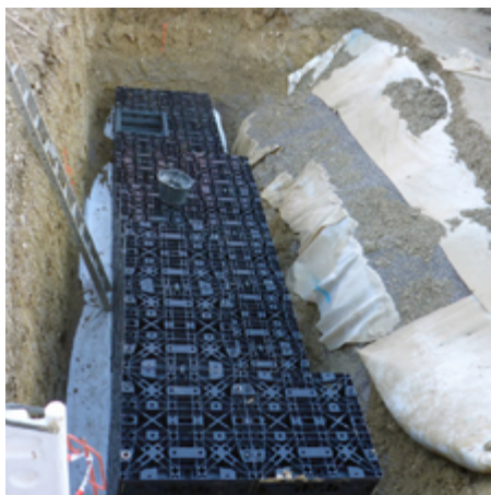
Die Versickerungsanlage wurde vor Ort aus 60 Rigolenkörpern EcoBloc 420 erstellt
